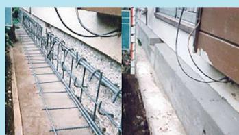
ひび割れの原因をなくし、ひび割れ補修をすることで中の鉄筋のサビの進行を抑えます。
