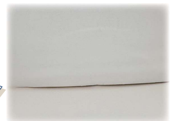
天井のふくらみ
