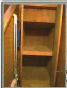
**工夫①** 階段の形状に合わせて天井を仕上げる事で、天井までの高さ2.1mを確保し、圧迫感が無く、且つ洞窟の様な丁度良く落ち着けるトイレになりました。
