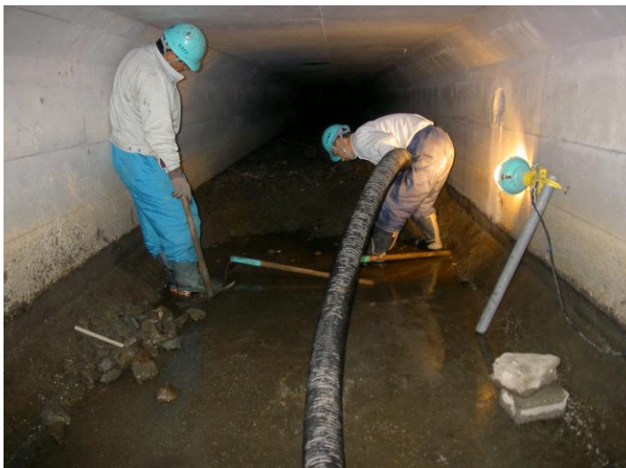
ホース先端の堆積土砂吸引状況
