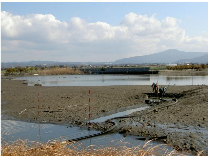
ホース先端の堆積土砂吸引状況
