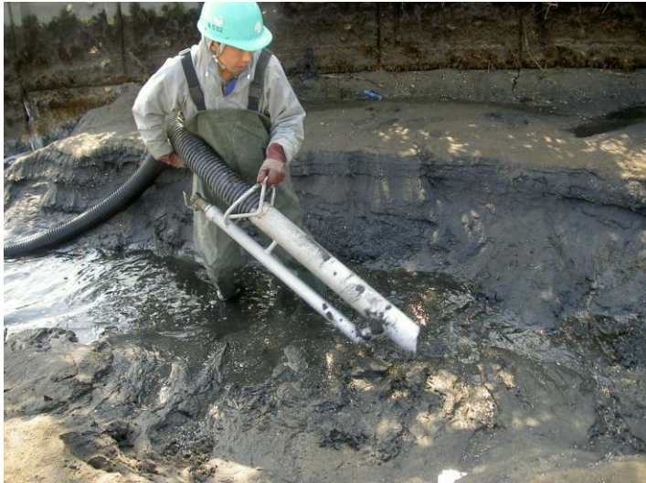
ホース先端の堆積土砂吸引状況
