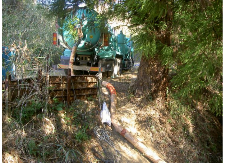
吸引土砂捨状況
